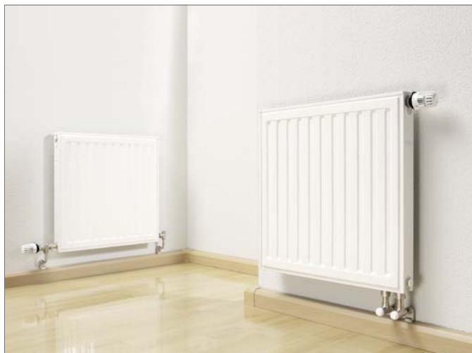
Obr. 16-1 Systém připojení otopných těles ze soklové lišty
