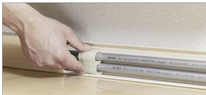
Obr. 16-36 Zaklapnutí držáku topných trubek
