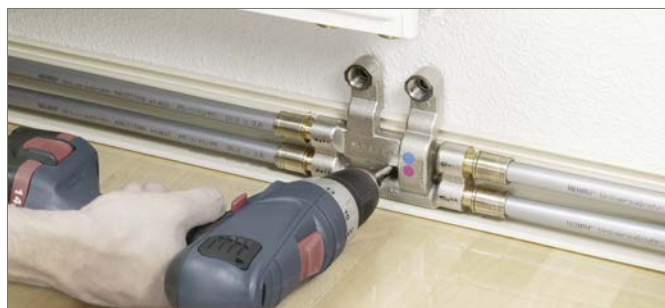
Obr. 16-35 Upevnění SL křížové fitinky RAUTITAN
