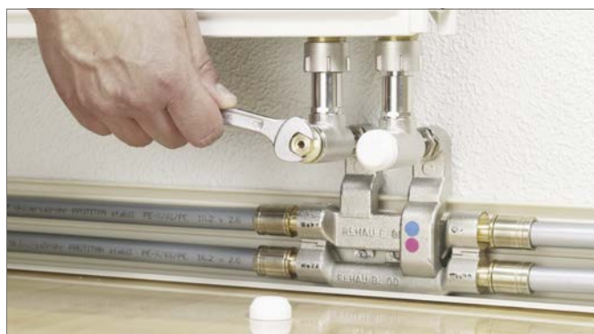
Obr. 16-38 Svérné šroubení pevně utáhněte
