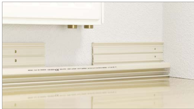
Obr. 16-43 Namontovaný dolní díl soklové lišty RAUDUO s vyseknutím
