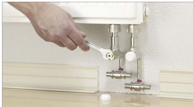
Obr. 16-45 Svěrné šroubení pevně utáhněte
